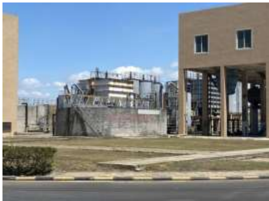
废水处理设施区域 (1)
