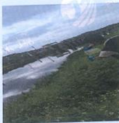
W1 盐岭河赤州水闸上游 300m
