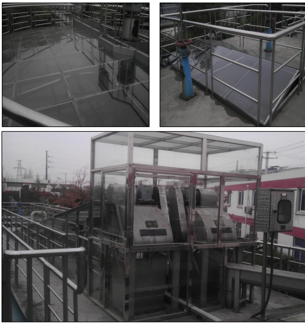
图 4-1 污水处理厂加盖收集系统案例
