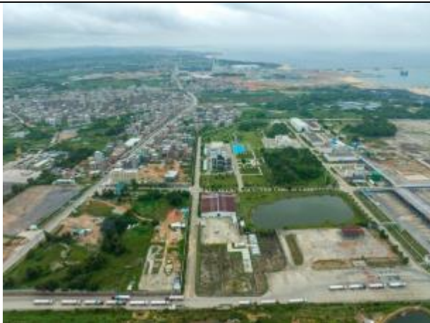
项目东侧航拍图
