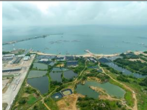
项目南侧航拍图
