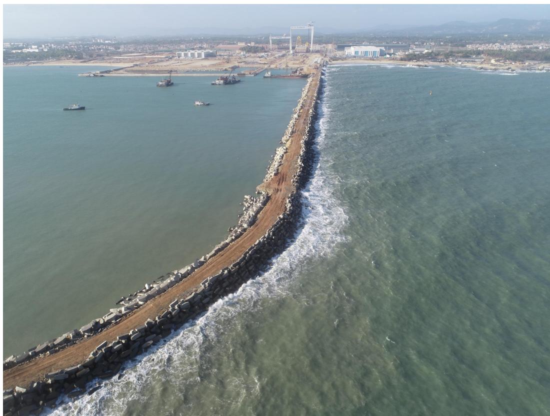
图 2.2.3-4 防波堤现状（转角）
