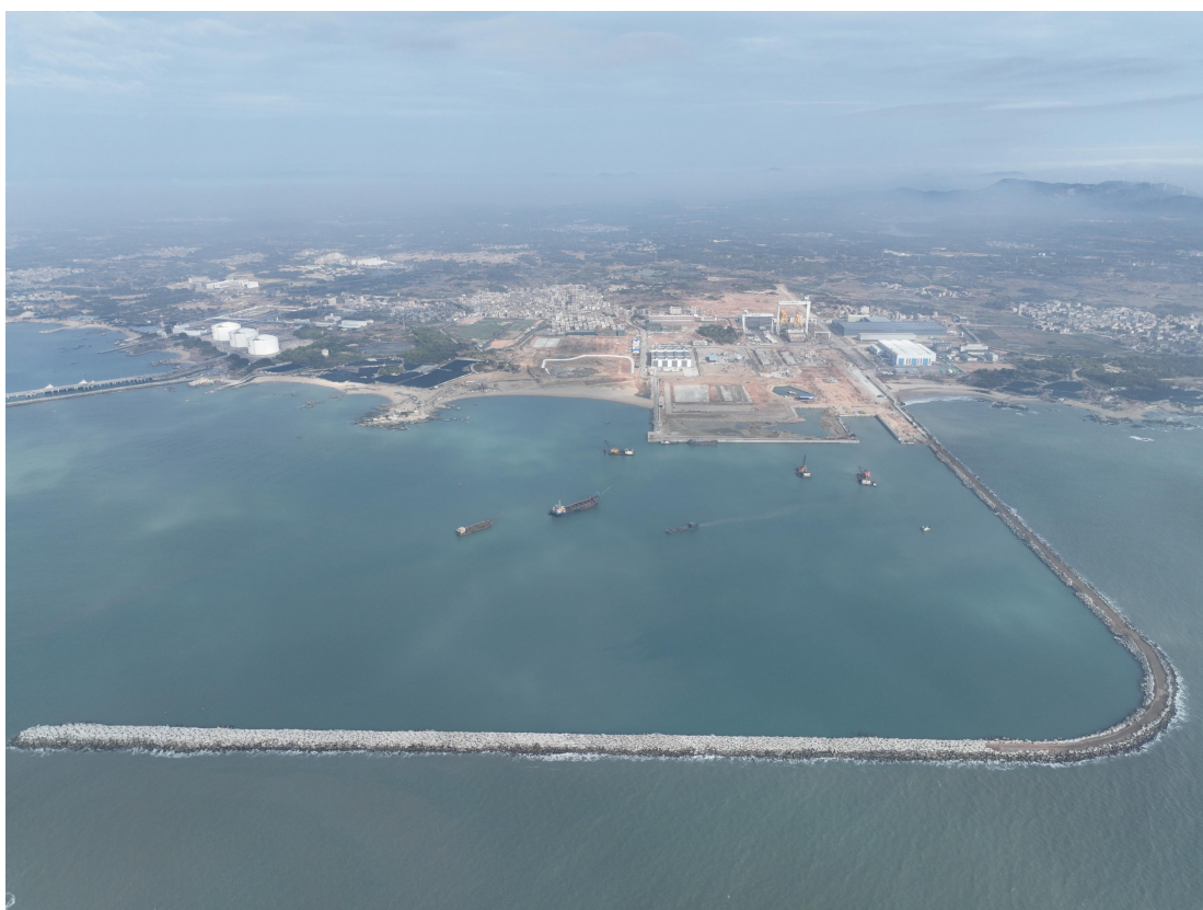
图 2.2.3-3 防波堤建设现状
