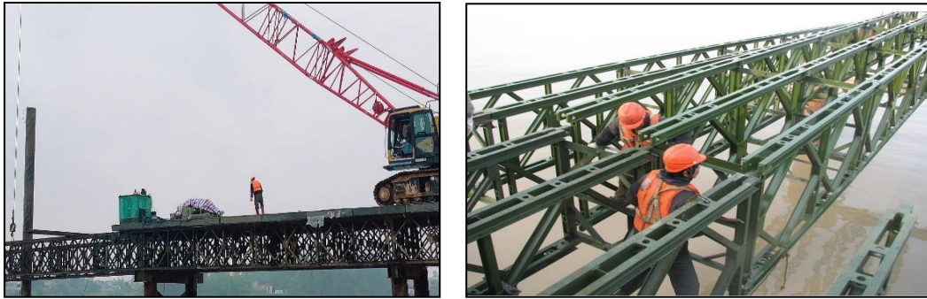
图 2.3.1-15 贝雷梁吊装示意图
