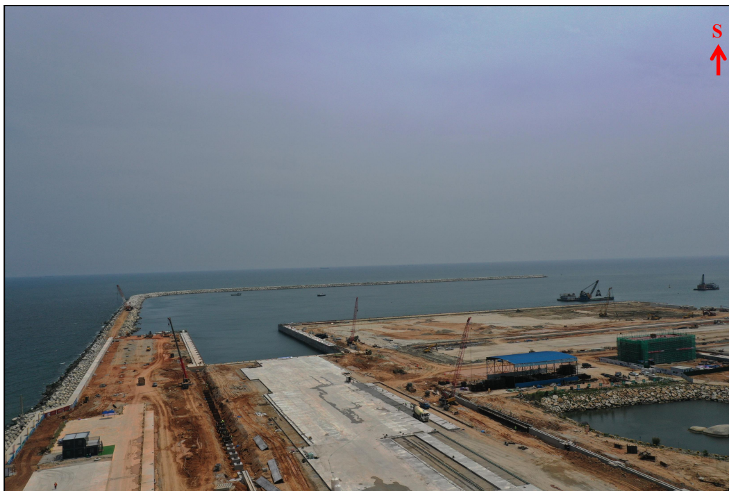
图 2.1.2-3 工程建设现状图（拍于 2024 年 5 月）
