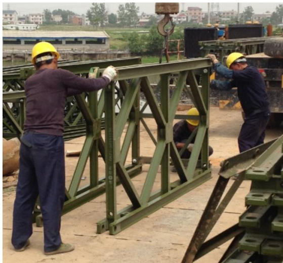
图 2.3.1-12 安装第二个支撑架图
