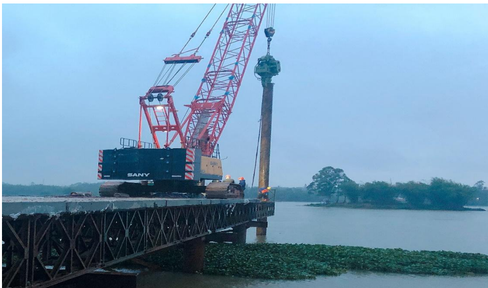
图 2.3.1-6 钢管桩沉桩示意图
