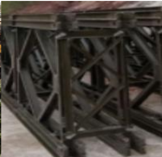
图 2.3.1-13 吊起第三片贝雷用贝雷销对其之间进行连接固定
