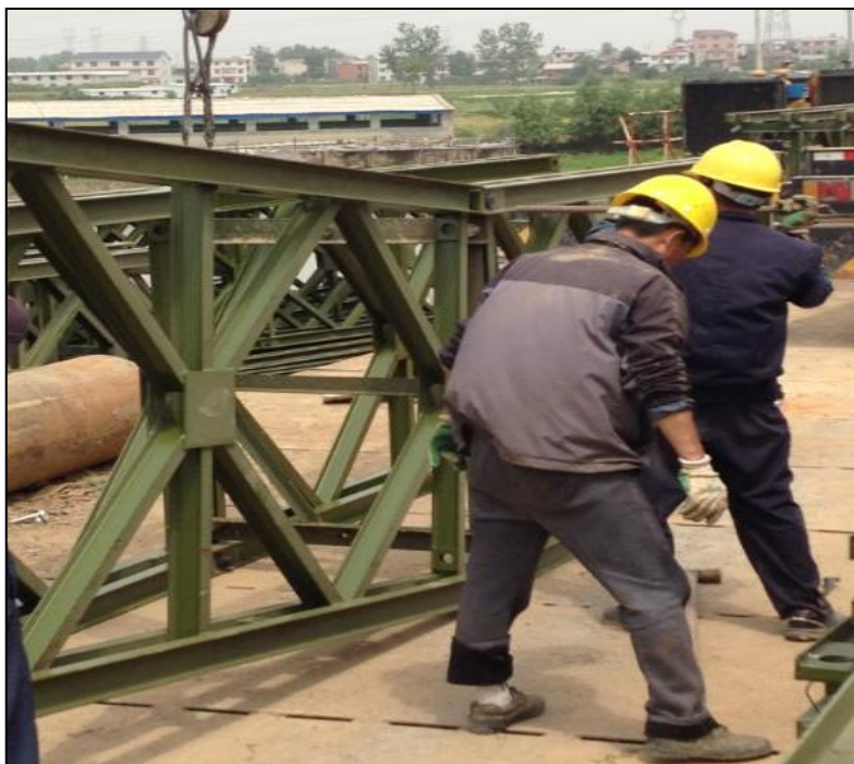
图 2.3.1-14 安装第四片贝雷直至整个贝雷组拼接完毕
