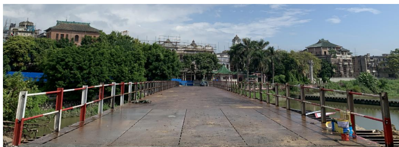
图 2.3.1-16 桥面板安装示意图
