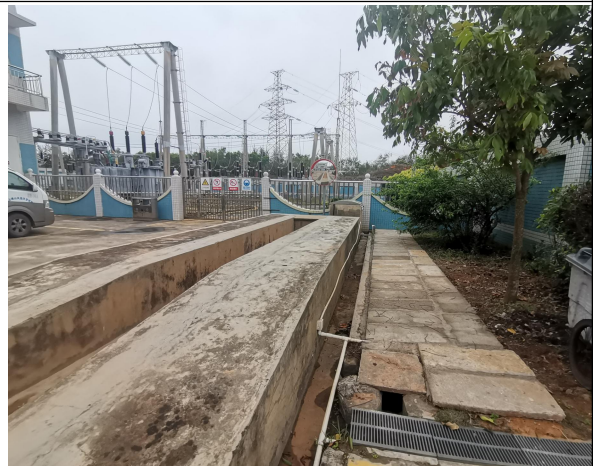
升压站内排水沟
