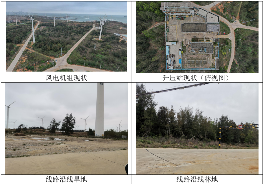
图 3-1 工程区域地形地貌及沿线情况图
