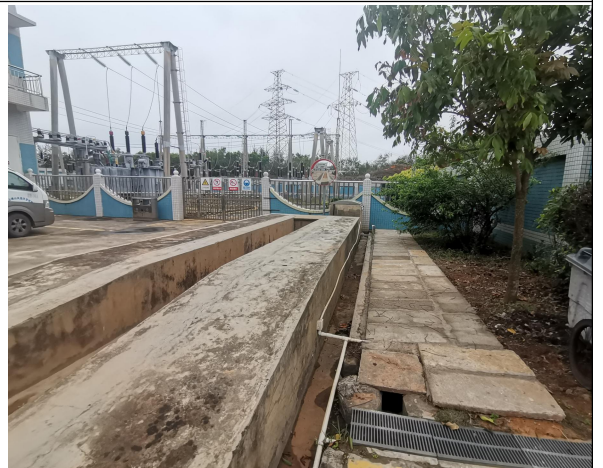
升压站内排水沟
