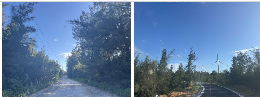
图 2-3 施工道路现状
