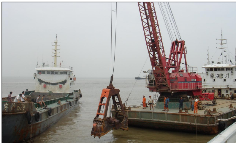
图 2.3.1-2 抓斗挖泥船和泥驳
