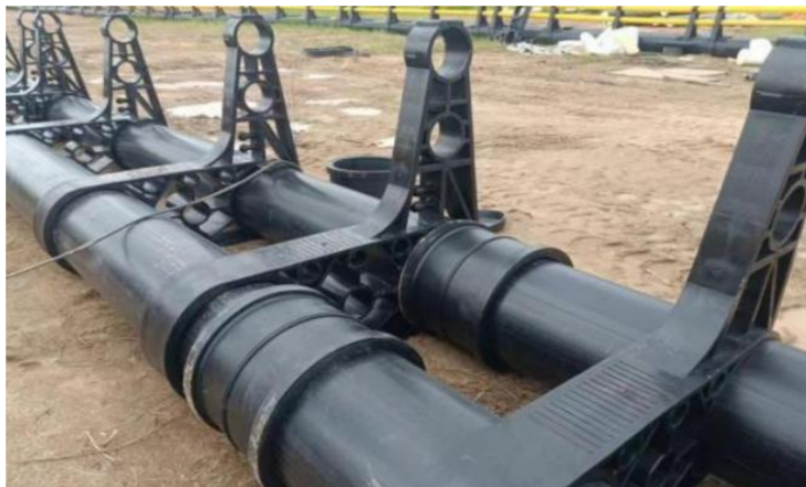
图 1.7-1 支架安装示意图
